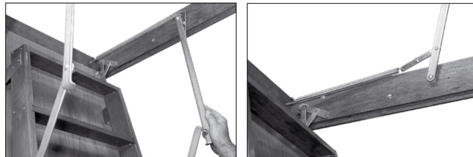
**4** Verificar se o batente está no esquadro fechando a tampa, caso não esteja ajustar o esquadro e nivelar o restante do batente. Se estiver tudo no esquadro e nivelado fazer a fixação do batente com espuma de poliuretano.
